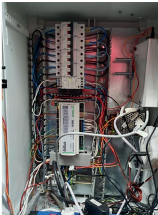
2) Carte commande émetteur des ordres au cimier, l'antenne émettrice a fait un défaut, on a dessoudé l'ancienne et placé la nouvelle dans le petit boîtier blanc sous les relais, depuis, le fonctionnement est instantané, et il reçoit l'état des fins de courses correctement
